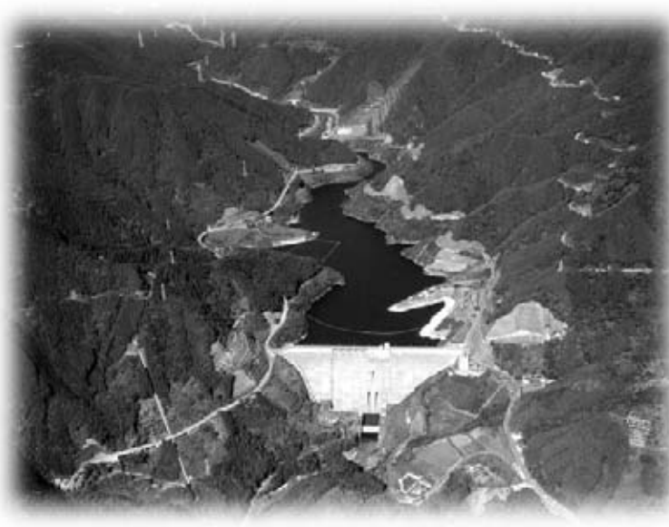
厳木ダム全景
