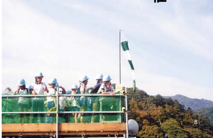
ダム建設現場見学
