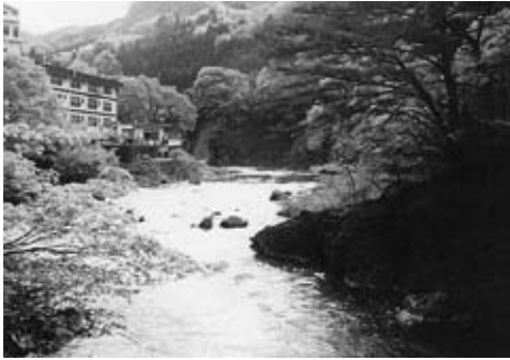
七ヶ宿ダムの直下流の状況（清流回復事業前）
