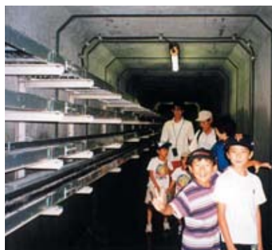
ダム堤体内見学
