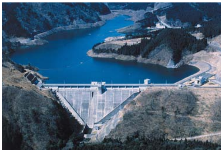
東荒川ダム全景
