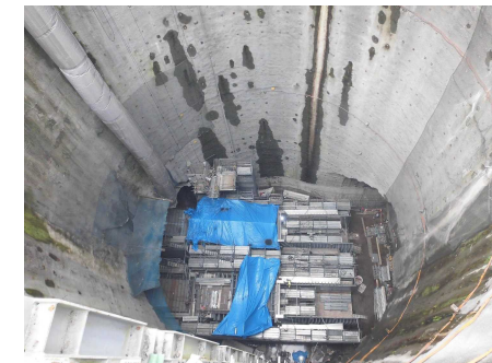
ゲート室部(H29.8)
