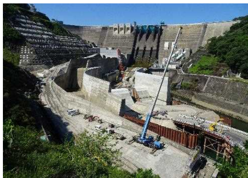
改造工事状況(H29.8)
