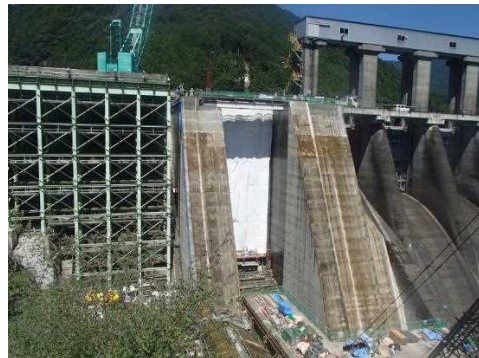
堤体切削状況(H29.8)
