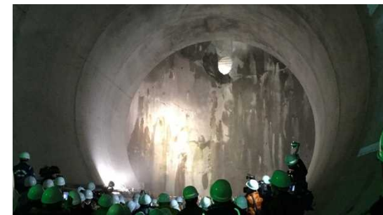
トンネル洪水吐 貫通(H27.12)
